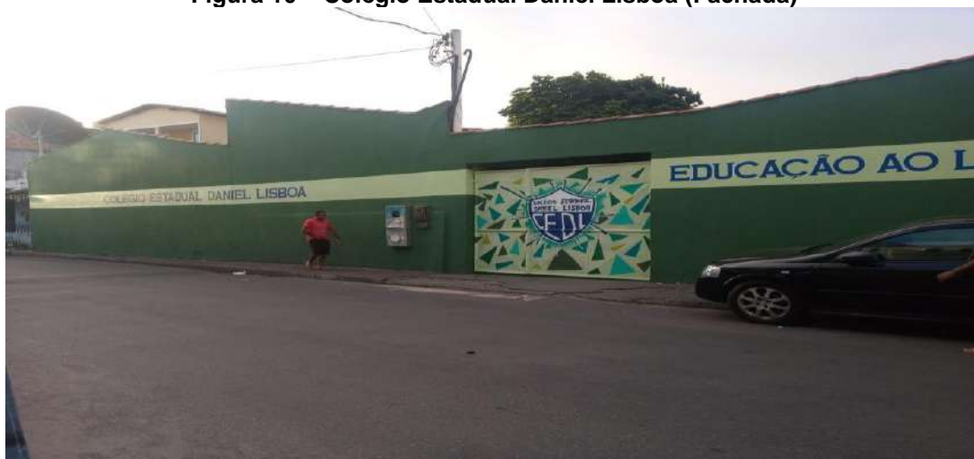
Figura 10 – Colégio Estadual Daniel Lisboa (Fachada)
