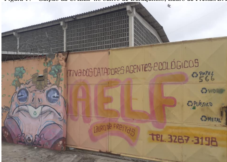
Figura 17 - Galpão da CAELF no bairro de Buraquinho, Lauro de Freitas/BA
