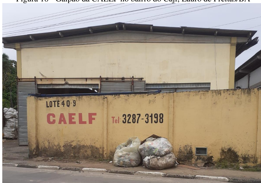
Figura 18 - Galpão da CAELF no bairro do Cajá, Lauro de Freitas/BA
