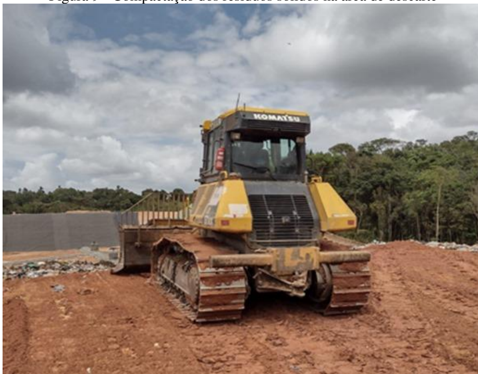
Figura 9 - Compactação dos resíduos sólidos na área de descarte
