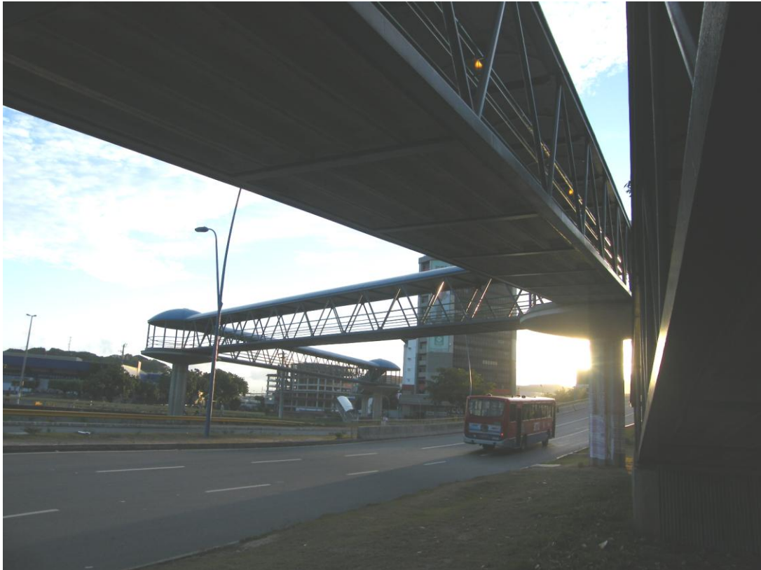
FIGURA 3.10 – PASSARELA CONSTRUÍDA PARA ATENDER A DEMANDA DE PEDESTRE
