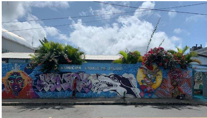
Figura 10 – Fachada da Escola Municipal Cidade de Jequié
