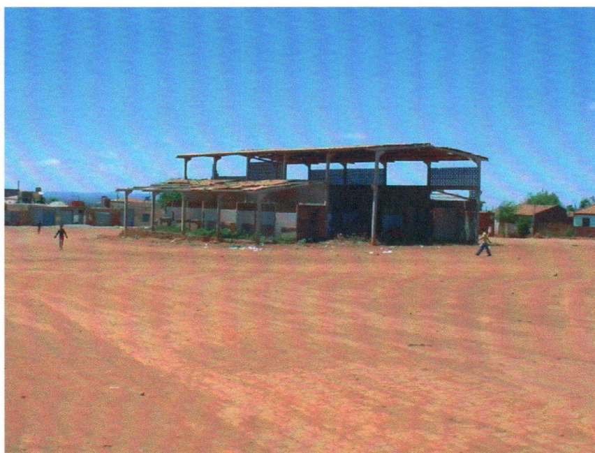
FOTO 19: ANTIGO CENTRO DE ABASTECIMENTO – UMBURANAS
