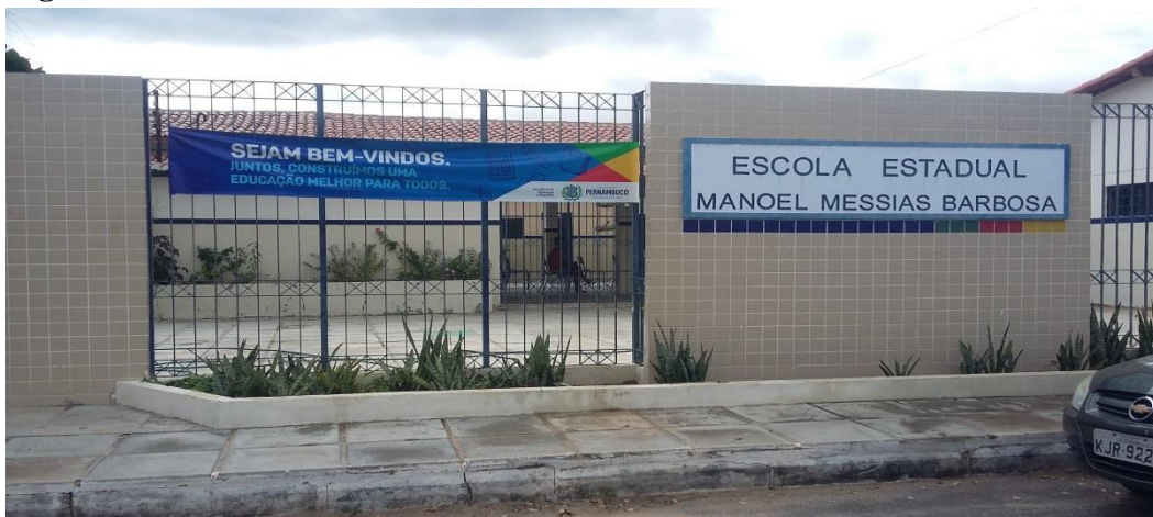
Figura 9 – Fachada da escola
