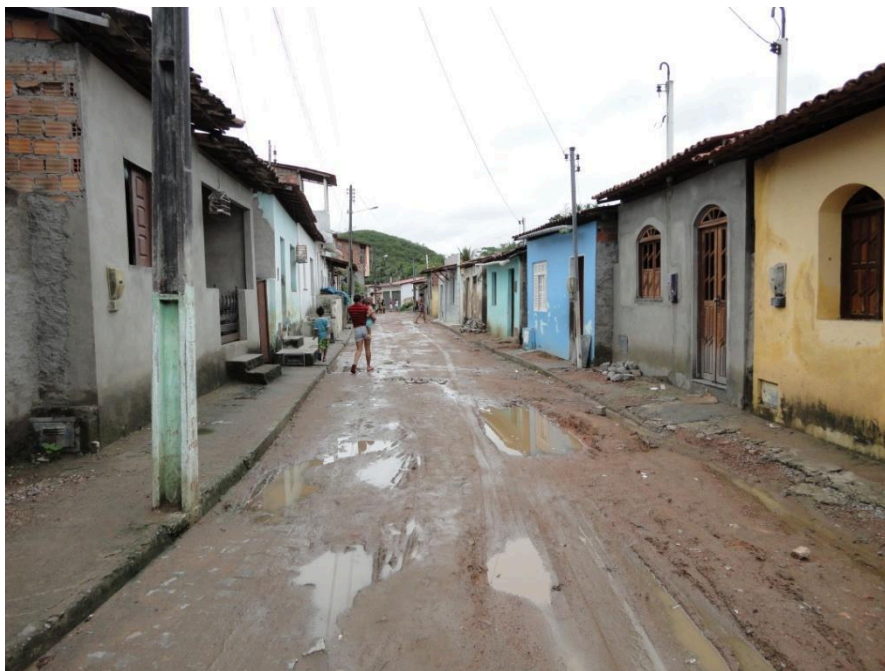
FIGURA 37: RUAS SEM ASFALTO
