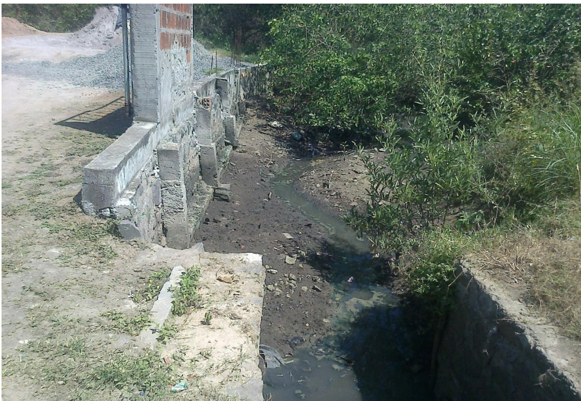
FIGURA 29 – ESGOTO IN NATURA NA COMUNIDADE DE NAGÉ – MARAGOGIPE-BA
