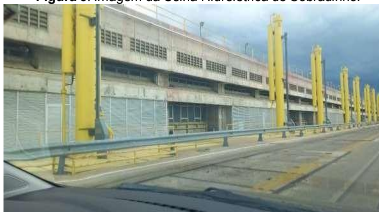
Figura 5: Imagem da Usina Hidrelétrica de Sobradinho.
