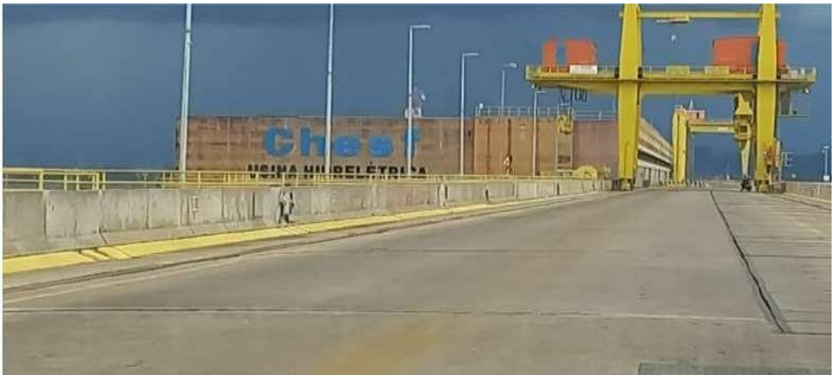
Figura 1: Imagem Frontal da Usina Hidrelétrica de Sobradinho.
