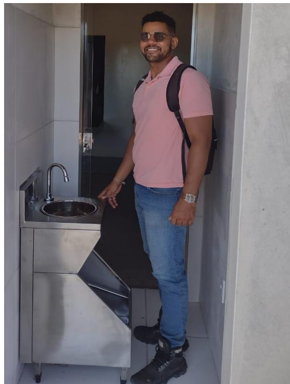
Figura 7. Lavatório de mãos e botas na barreira sanitária da agroindústria. Fonte: Arquivo pessoal.
