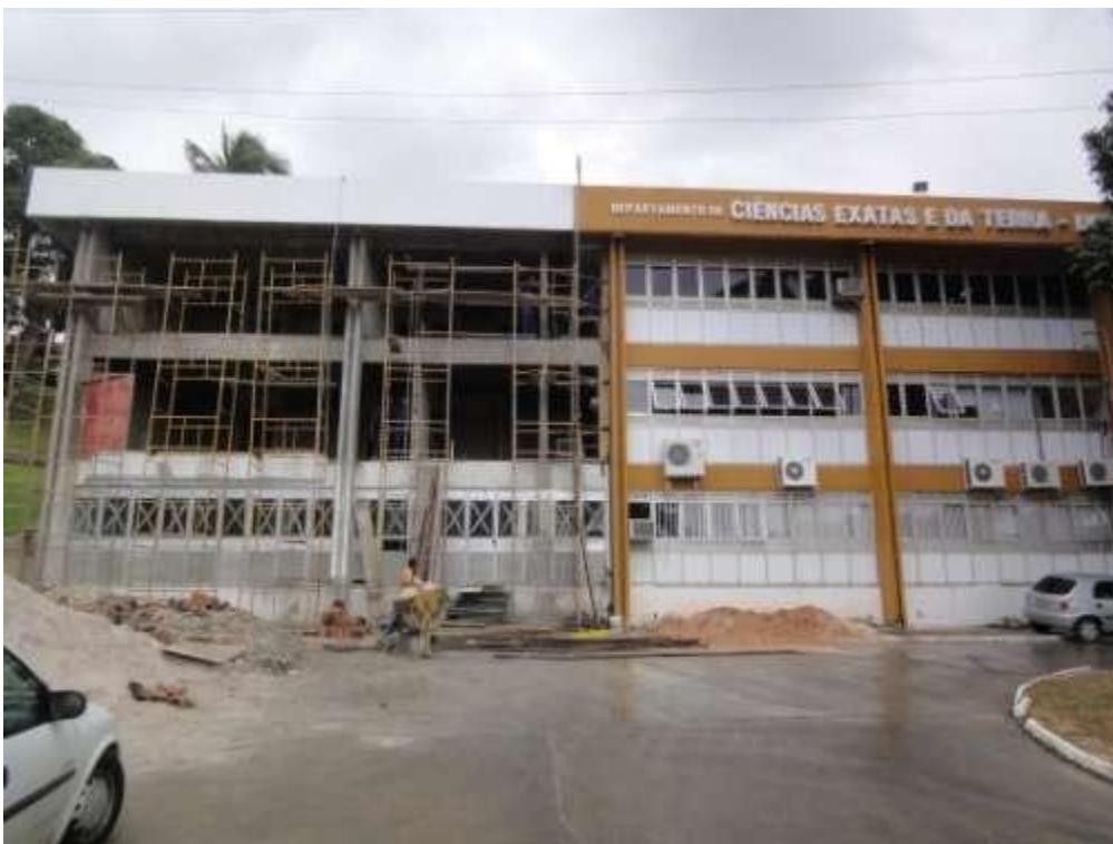
Foto 6 – Obra de ampliação do prédio de Química no Campus I da UNEB.
