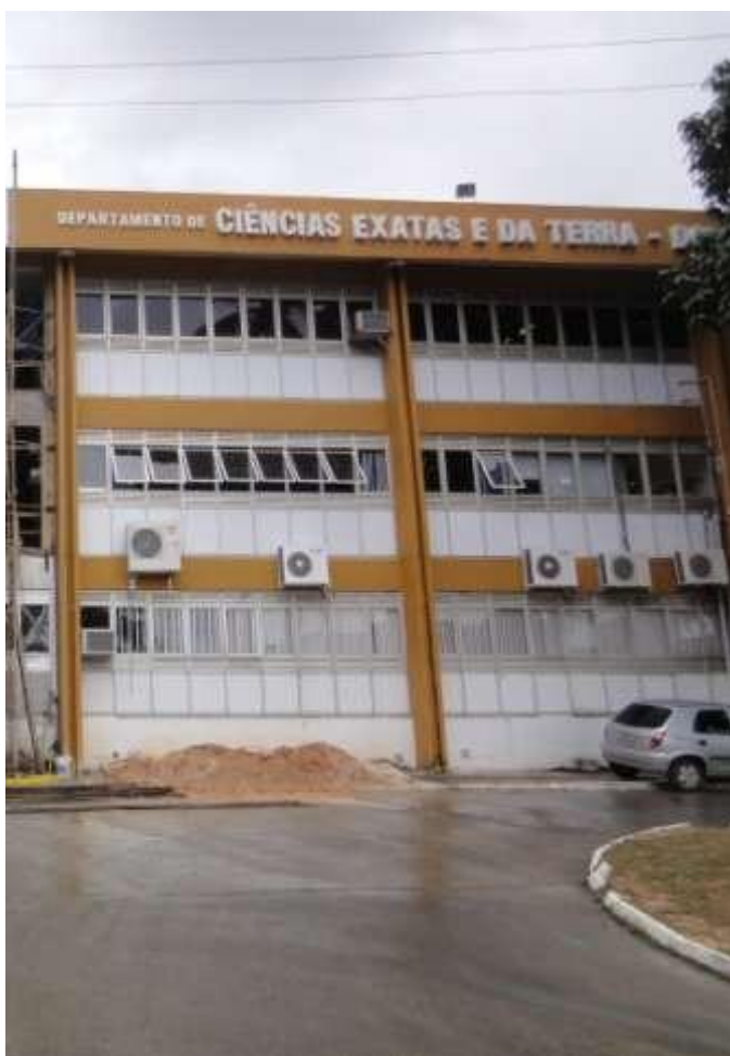
Foto 10 – Prédio de Química do Campus I da UNEB.
