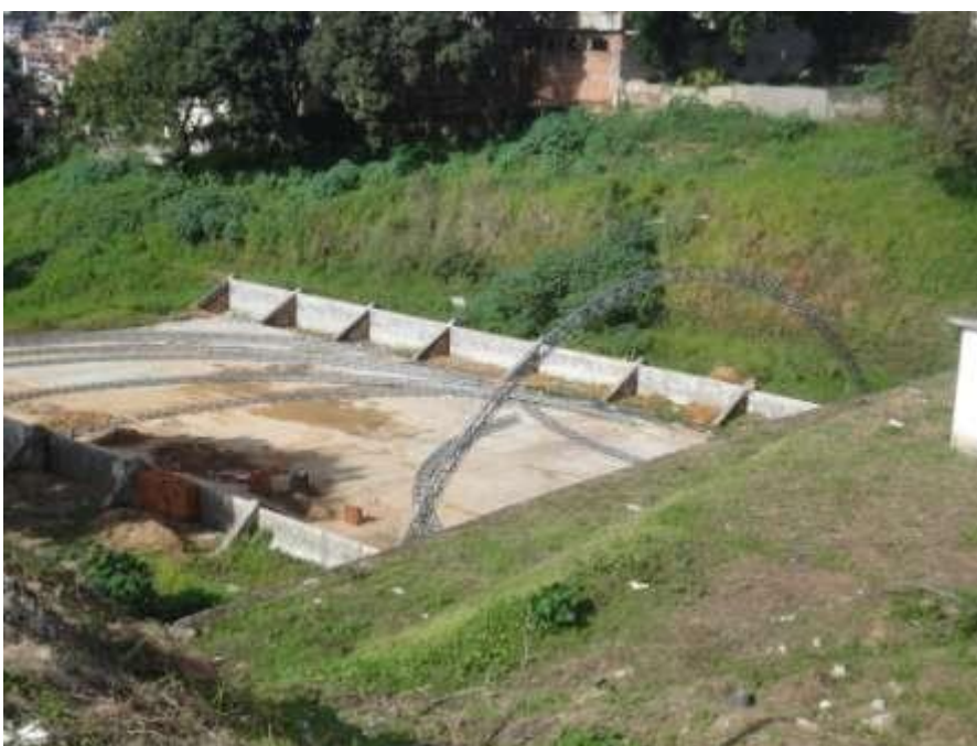
Foto 8 – Obra de construção do ginásio de esportes no Campus I da UNEB.
