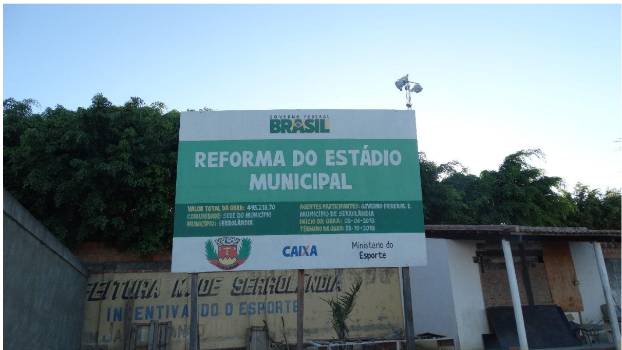
Foto 5: placa que indica início e final da obra de reforma do estádio Municipal- construção e reforma do estádio-Arquivo pessoal Marcio Ferreira.
