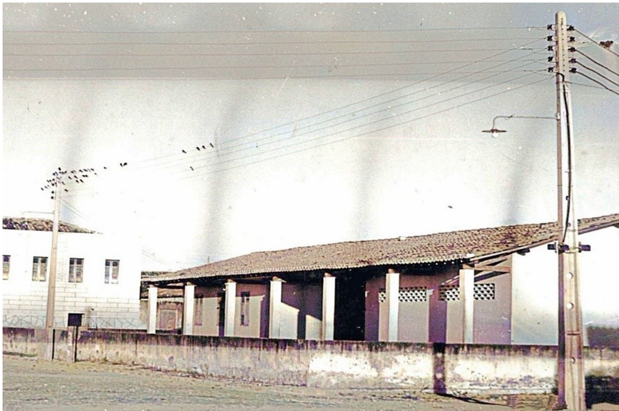
Figura 1 - Imagem frontal de um dos prédios do Ginásio de Pilão Arcado Velho
