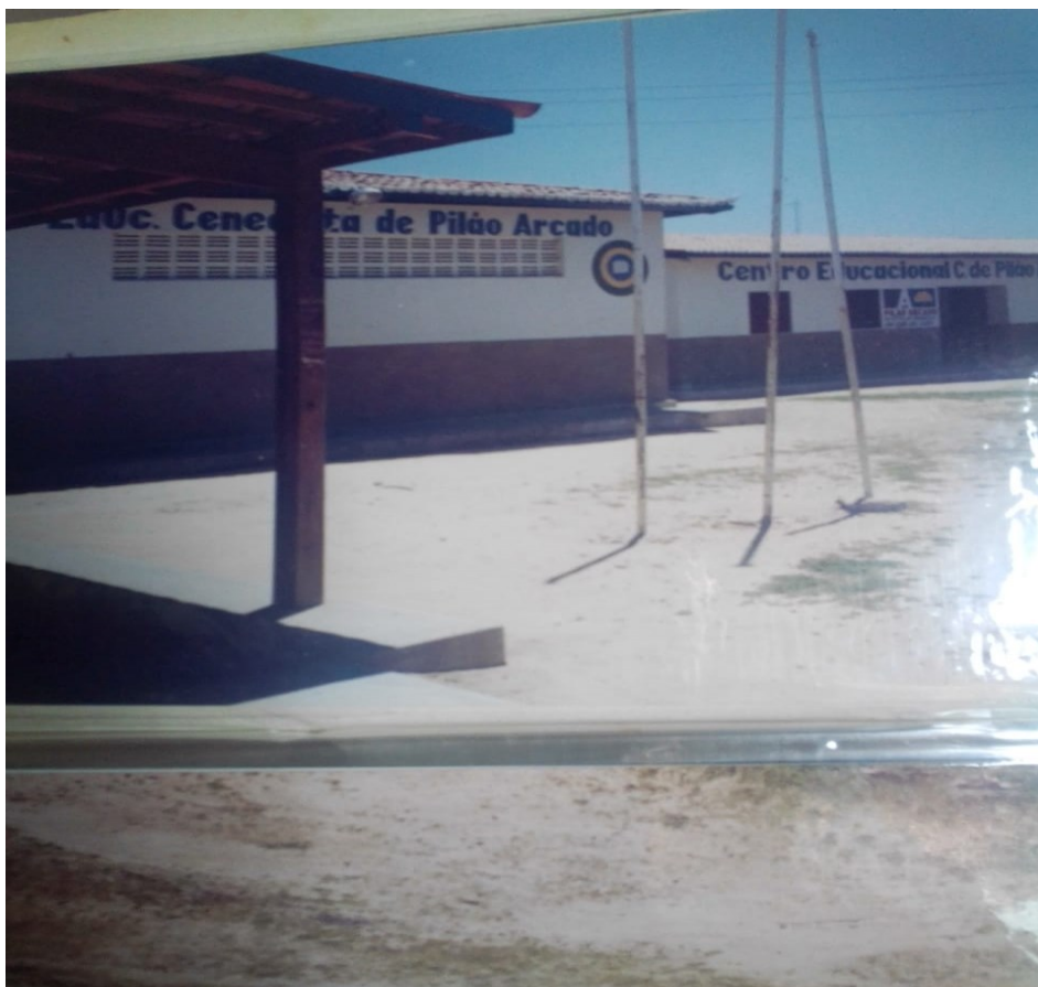
Figura 8 - Imagem frontal da CNEC em Pilão Arcado Novo
