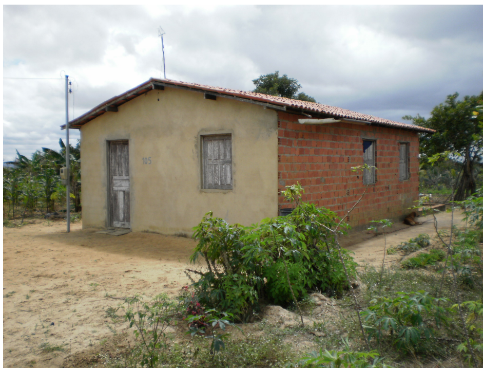
Fotografia 6 - Casa em bloco cerâmico tradicional, no assentamento
