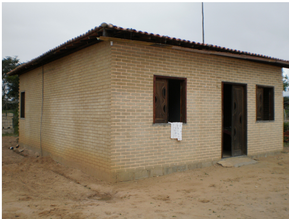
Fotografia 5 - Casa em tijolo ecológico, no assentamento
