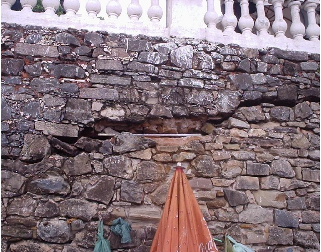
Foto 3.3 MURO DE CONTENÇÃO DA PRAIA DO PORTO DA BARRA
