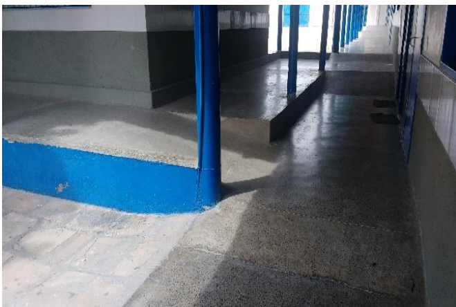
Figura 5 Pavilhão com rampas - não normativa
