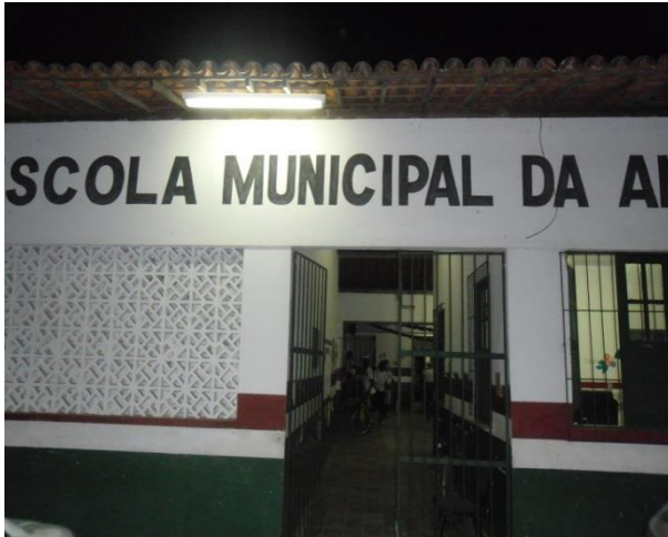
Foto 1 – Fachada da escola
