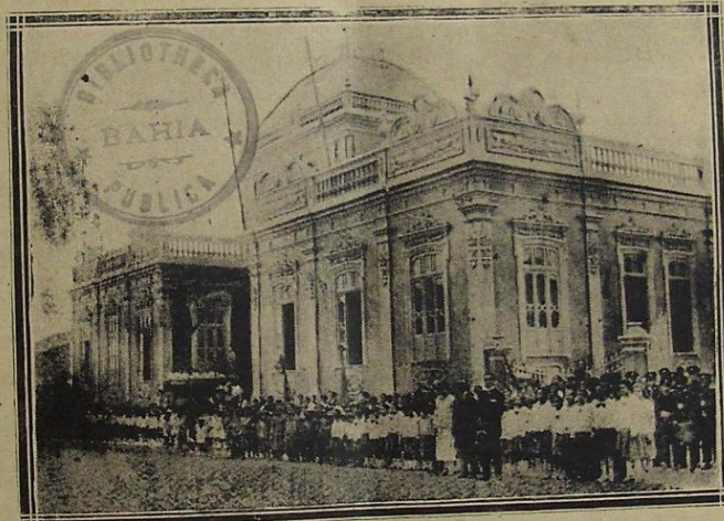
FACHADA PRINCIPAL DO GRUPO ESCOLAR "J. J. SEABRA" NA CIDADE DA FEIRA DE SANT'ANNA
