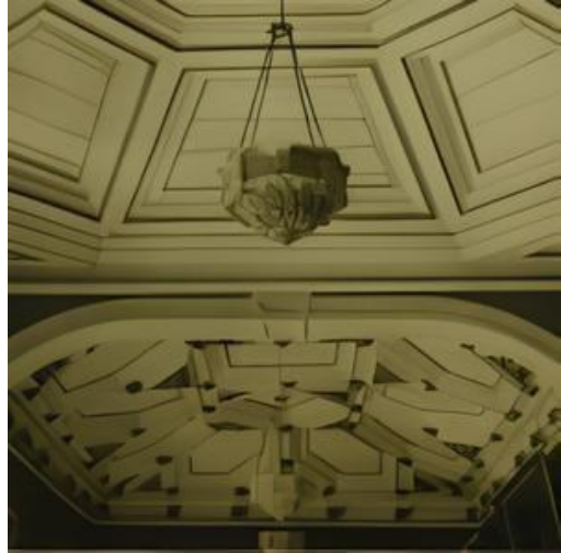
Figura 14: Casa à Rua Guedes de Brito, 14; Salão Nobre
