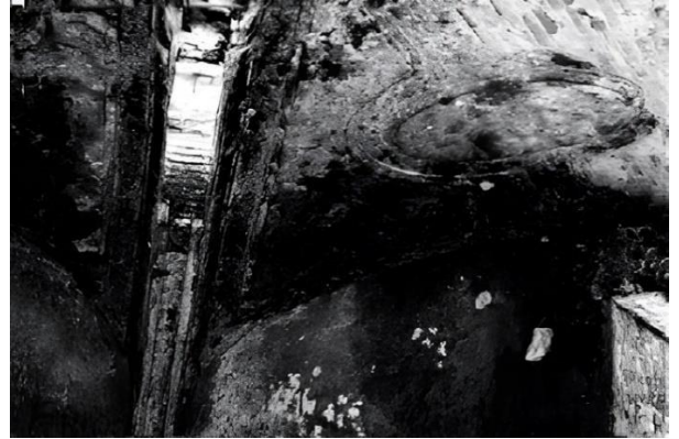
Figura 8: Detalhe do teto no interior da Casa
