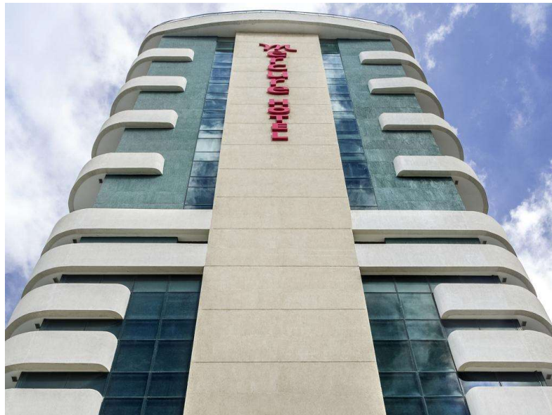
Figura 4 - Torre do Mercure Salvador Pituba.
