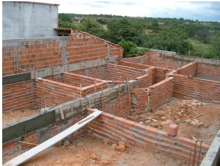
Figura 6- Construindo as paredes de uma casa. Fonte: Ivaildo, 2011.
