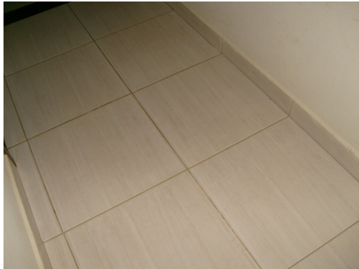
Foto 9 – Piso revestido por cerâmica. Fonte: Ivaildo, 2011.
