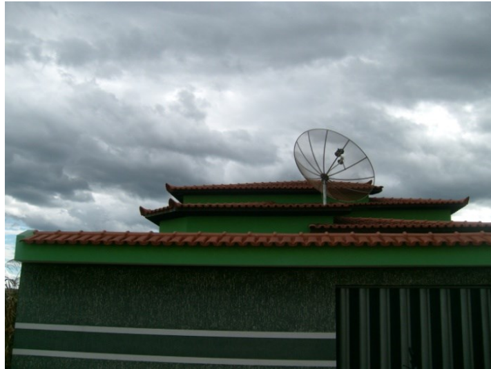
Figura 8- Modelo de telhado “a vista” feito com telha colonial. Fonte: Ivaildo, 2011.
