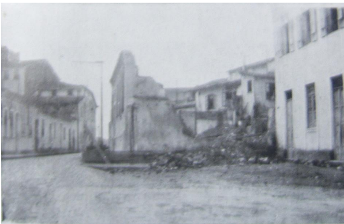
Fig. 10: Edificação Demolida – Av. Joana Angélica- administração Neves da Rocha
