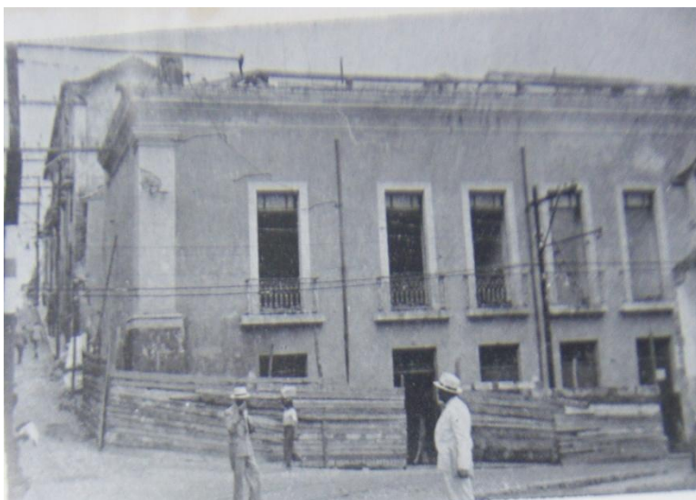
Fig. 9: Edificação a Demolir na Rua José Gonçalves no Distrito da Sé - administração Neves da Rocha
