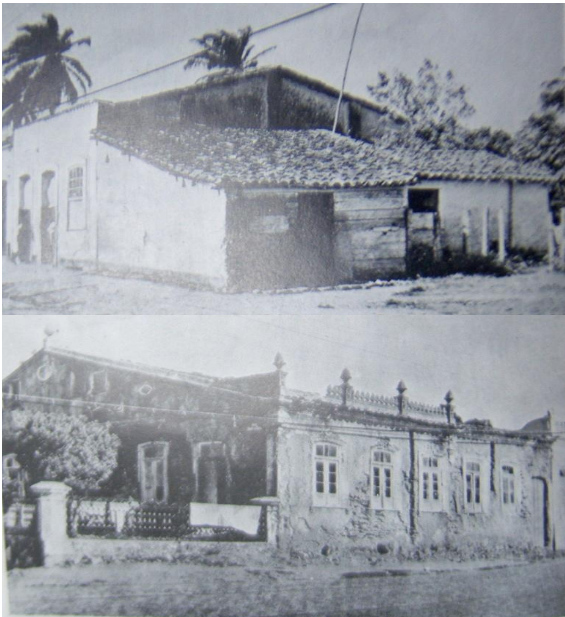
Fig. 8: Edificações a Demolir na Av. Bonfim na administração Neves da Rocha
