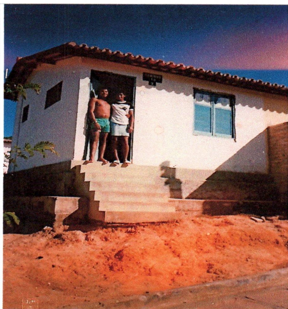
Figura 17: Residência antes das modificações Foto: Eliana Miranda, 1991.
