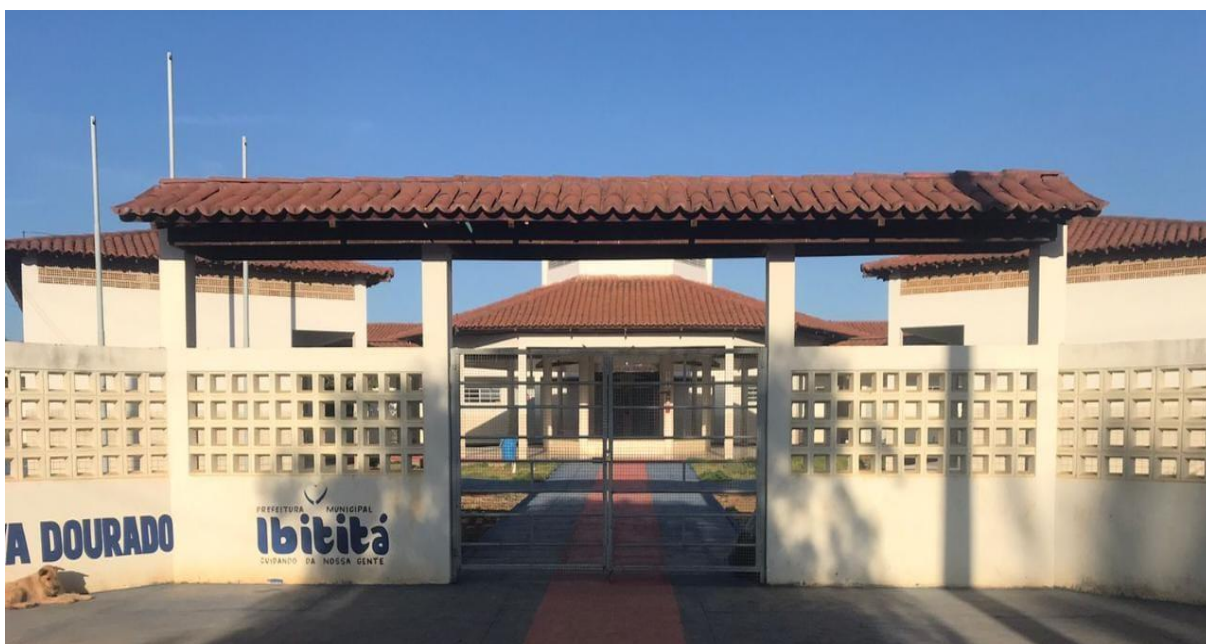
Figura 3: A escola da comunidade – foi construída após a certificação
