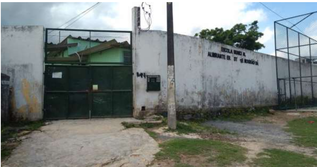
Figura 1- Fachada da Escola Municipal Almirante Ernesto de Mourão Sá
