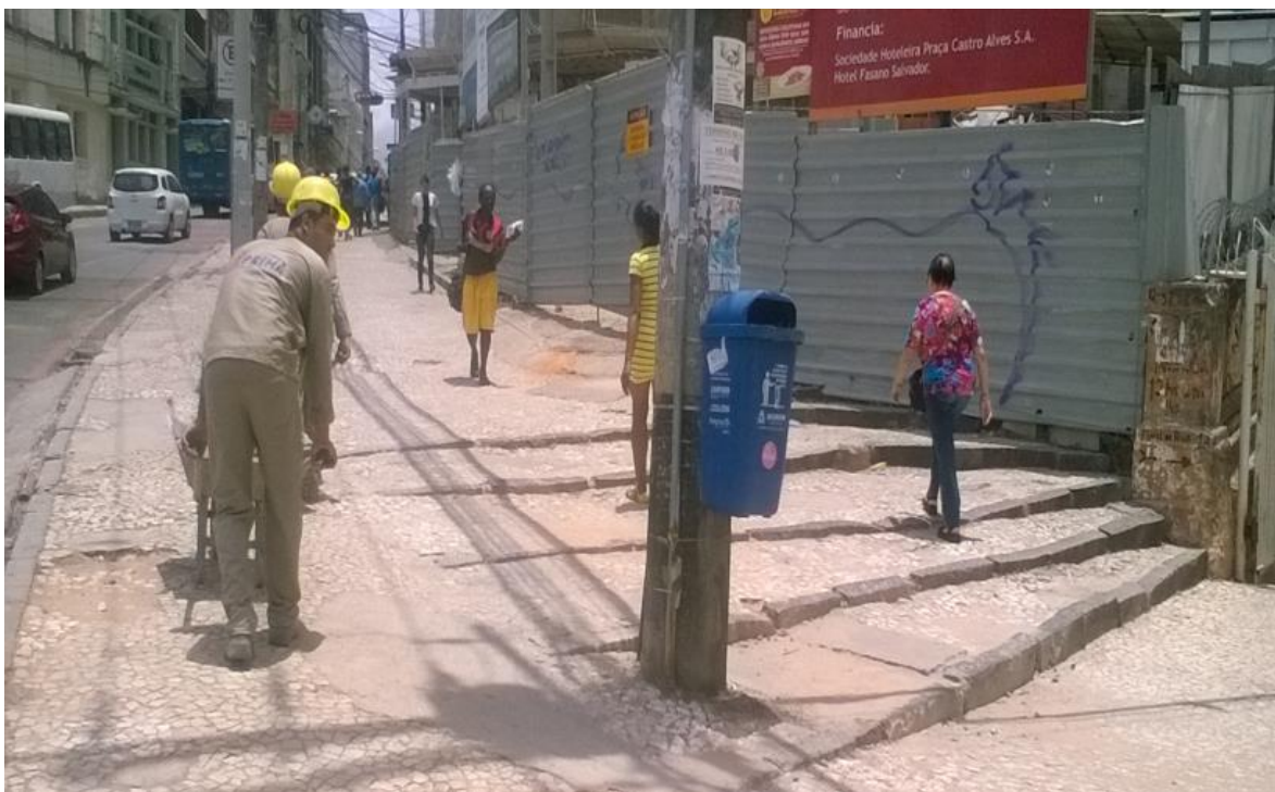
Figura 17 – Obra na Praça Castro Alves Fonte: Elaborado pela autora (2016)
