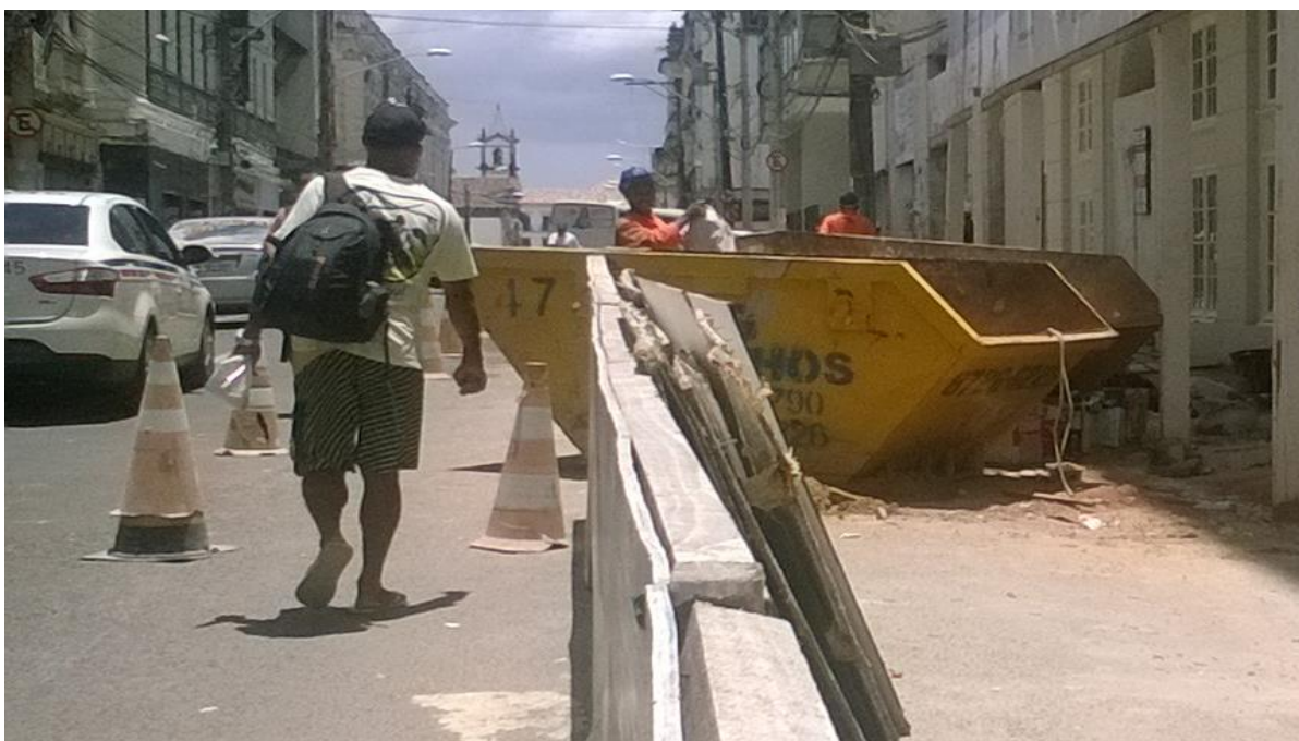
Figura 19 – Acesso comprometido na calçada do Hotel Palace, Rua Chile. Fonte: Elaborado pela autora (2016)
