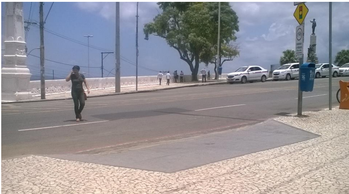
Figura 18 – Rebaixamento da calçada na Praça Castro Alves Fonte: Elaborado pela autora (2016)
