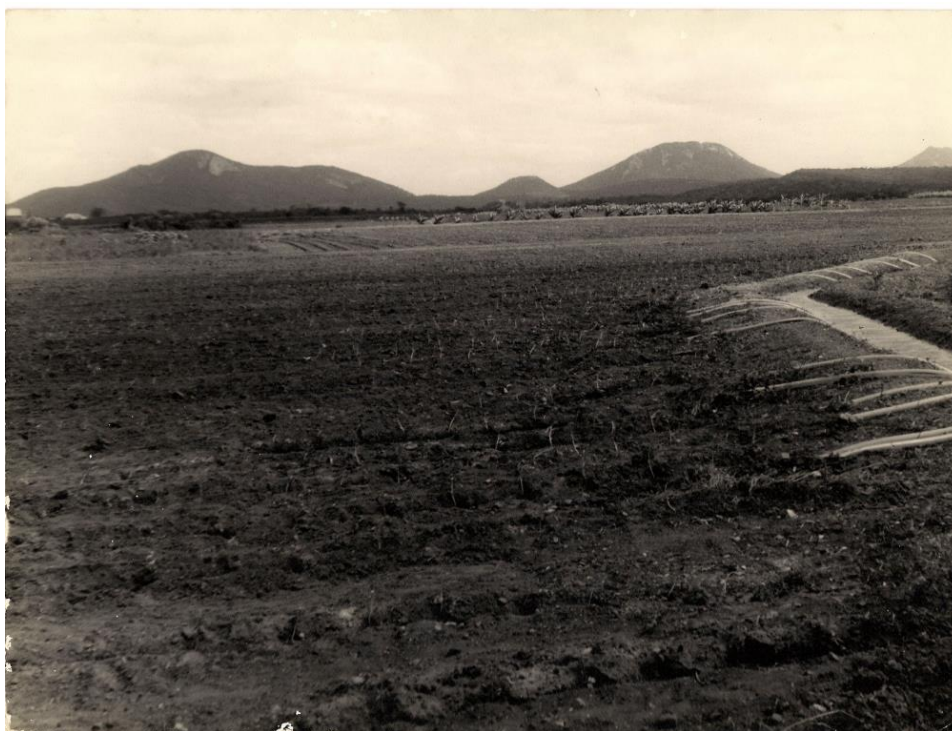
Figura 6 - Terraplenagem do Açude (1950).
