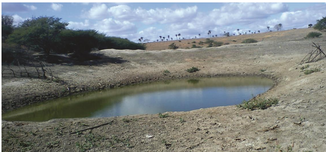
Figura 8 - Tanque construído no curso d'água do Riacho do Inchu.
