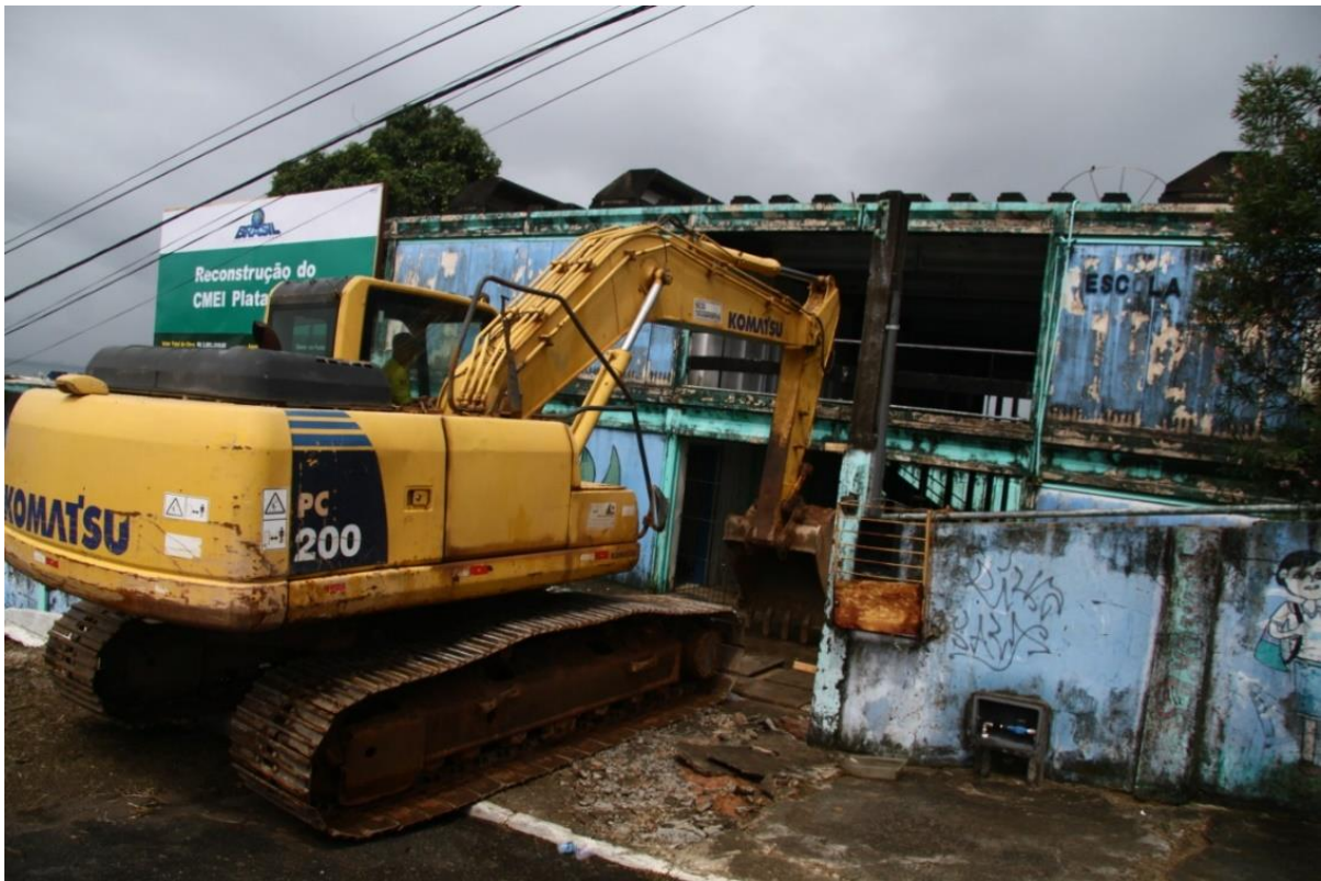
FIGURA 5 – DEMOLIÇÃO DA ESCOLA ANTERIOR EM 2016.
