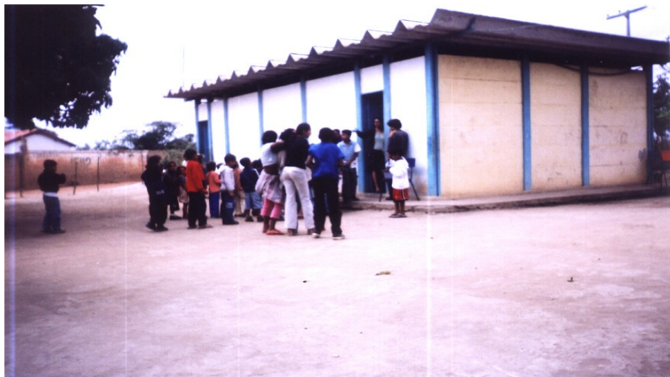
Foto 1 – Prédio da Escola Ana Gomes
