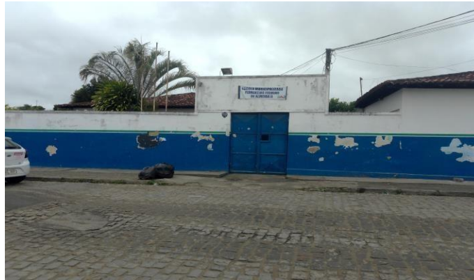
Figura 1 – Escola Municipalizada Florentino Firmino de Almeida
