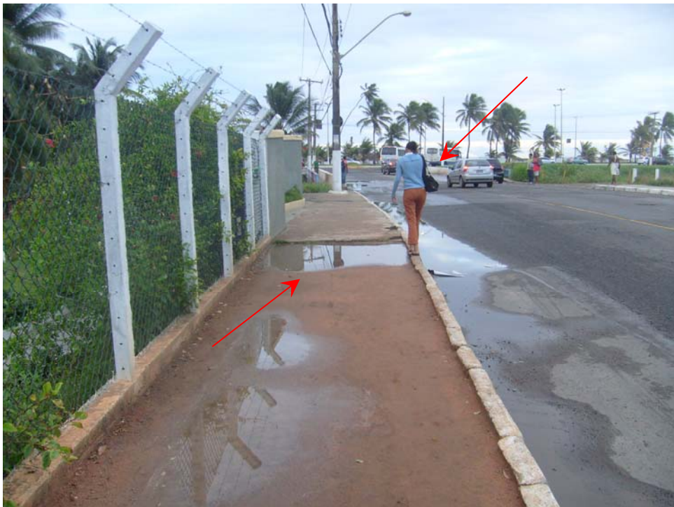
Figura 19: Calçada com drenagem deficiente.
