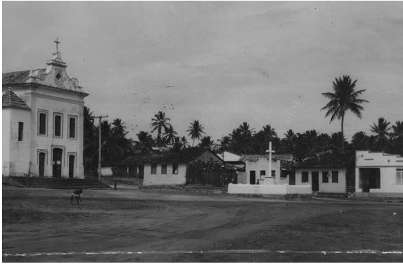
Figura 11: Igreja Nossa Senhora da Conceição de Itapuã (ano não informado) Fonte: Baiano, 2008
