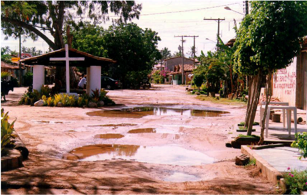
Figura 10 - Foto da Avenida ACM sem pavimentação – 1998.
