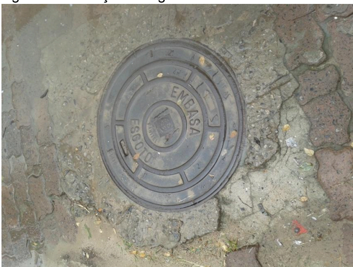
Figura 13- Serviço de Esgotamento Sanitário em Praia do Forte, 2013.
