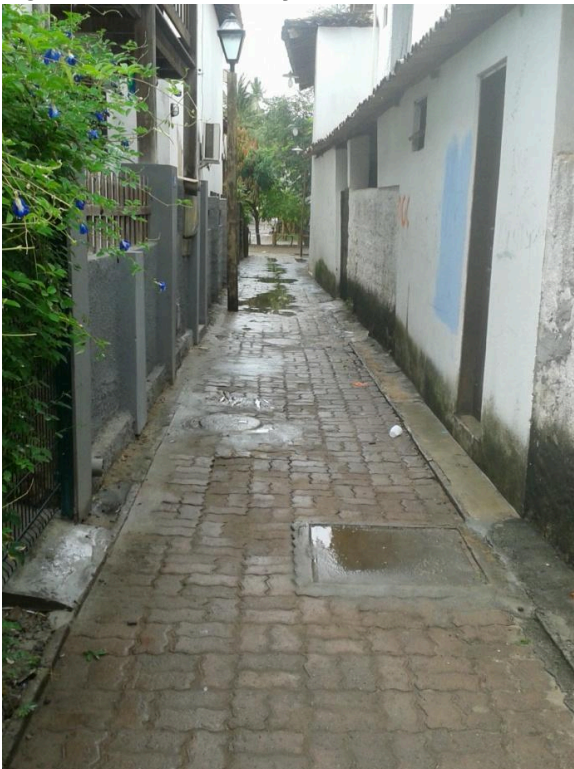
Figura 12- Pavimentação nos corredores das ruas em Praia do Forte, 2013.
