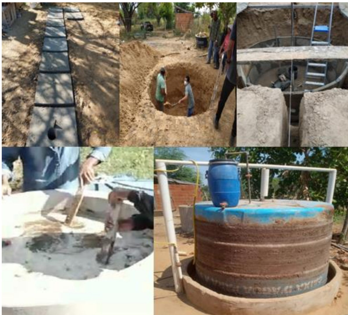
Figura 30 – Etapas de construção do biodigestor
