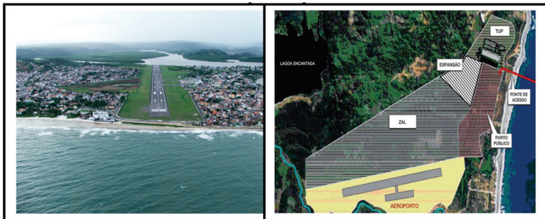
Fotografia 11 – Pista atual do aeroporto de Ilhéus e o projeto do futuro aeroporto desenhado sobre o complexo do porto Sul, Bahia, 2010
