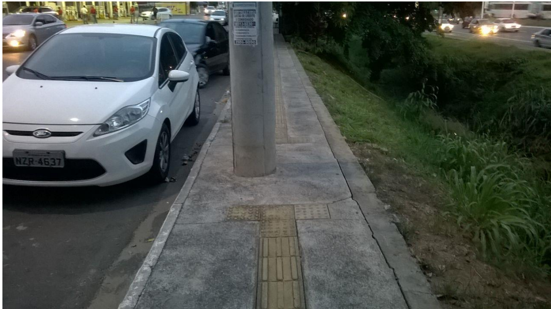
Figura 11: Calçada na Avenida Antônio Carlos Magalhães
