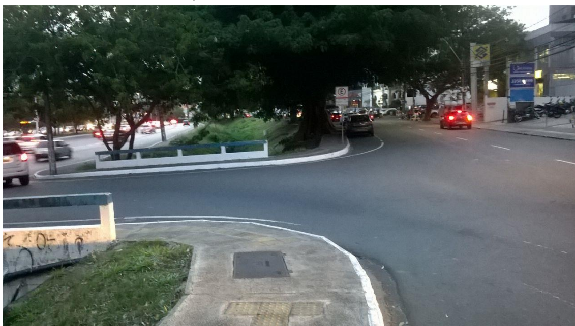
Figura 13: Interseção sem faixa de pedestre na área de estudo
