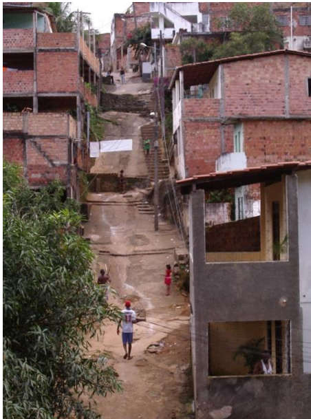
Foto 10 - Escadaria sem manutenção Silvia Ogawa, ago. 2003.
