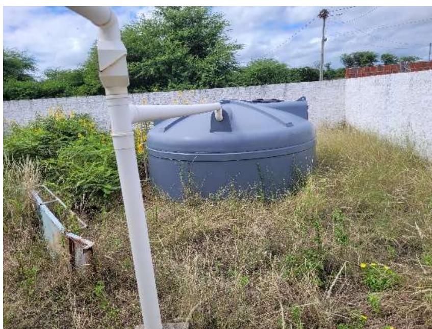
Figura 11 - Área externa descoberta da Emei VIII, 2024.
