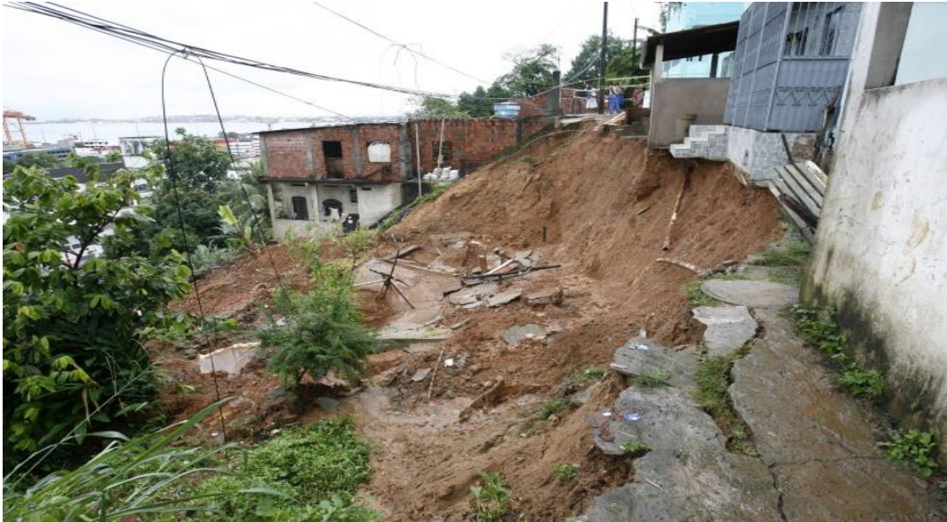
Figura 17 – Deslizamento de terra seguido de desabamento de imóvel em Santo Antônio Além do Carmo - 2011
