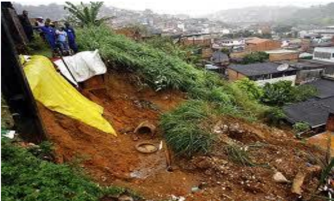
Figura 19 – Deslizamento de terra em Fazenda Grande II - 2012
