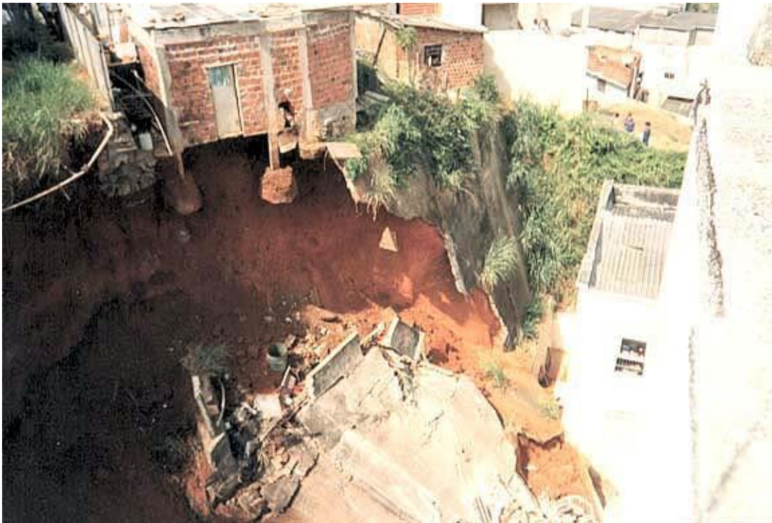
Figura 11 – Deslizamento de terra no Morro do Gavazza - 1998
