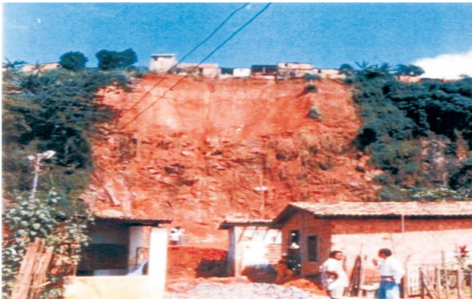
Figura 10 – Deslizamento no bairro de São Gonçalo do Retiro - 1995
