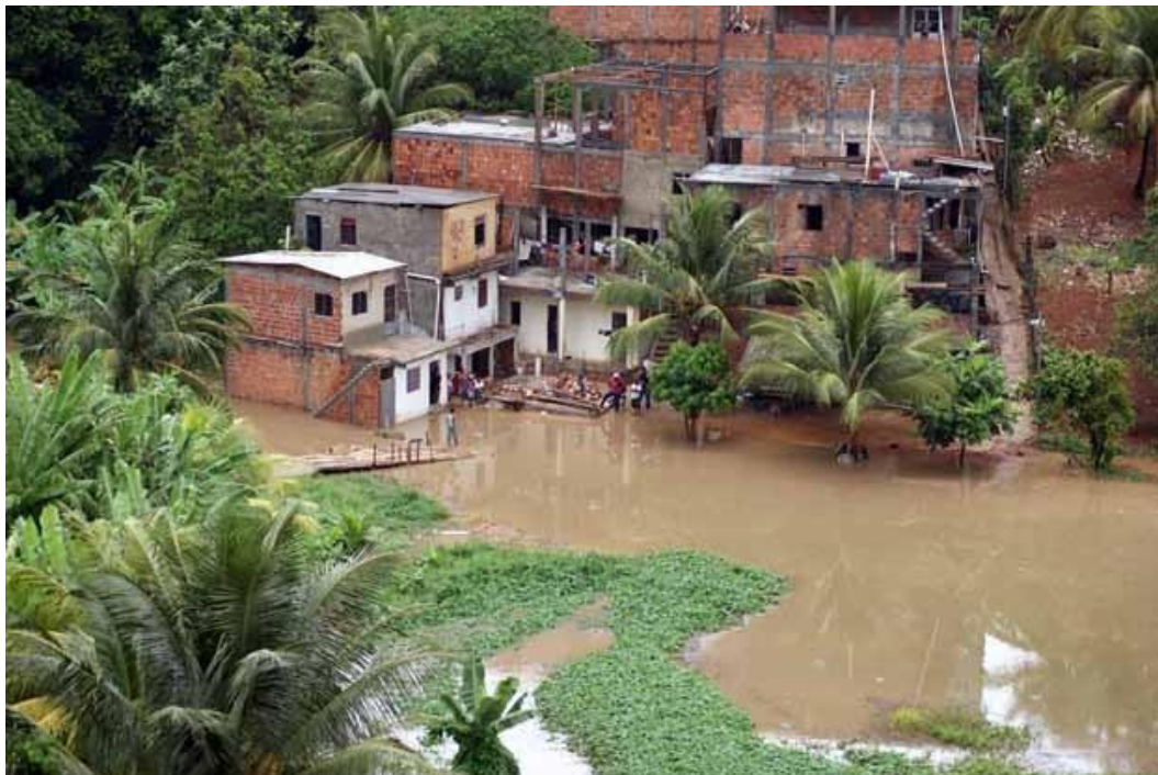
Figura 23 – Inundação no Doron – 2 013
