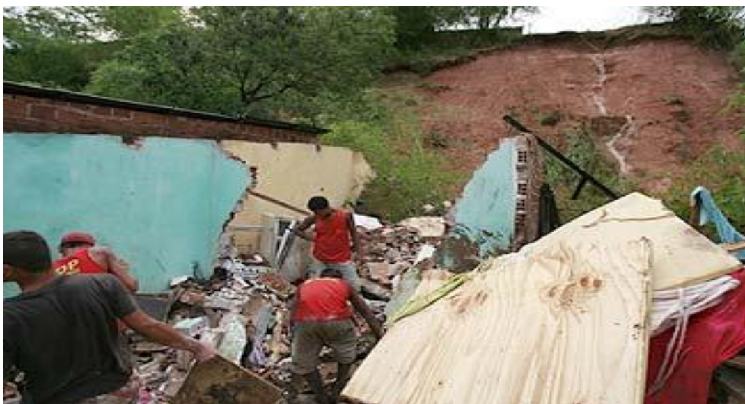
Figura 18 – Desabamento de imóvel em Dom Avelar - 2011
