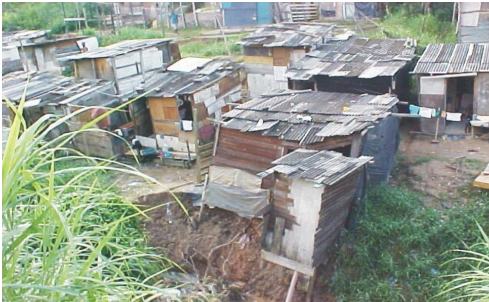
Figura 12 – Ameaça de deslizamento de terra em Paripe – 2002
