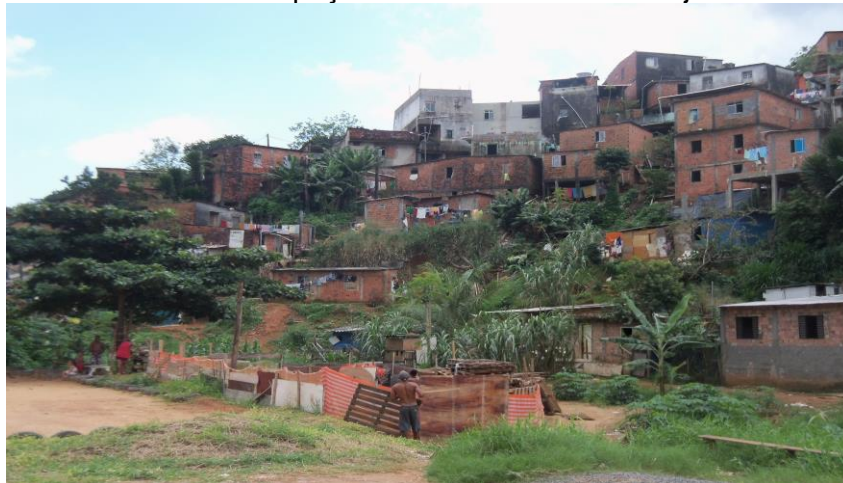
Foto 2: Vista ocupação de encosta - Jardim Cajazeiras
