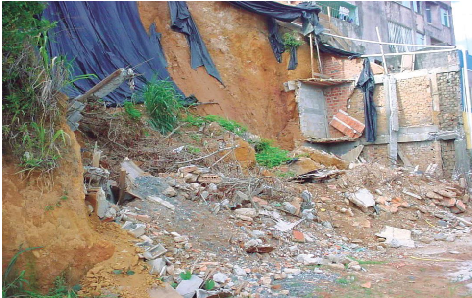
Figura 13 – Deslizamento de terra seguido de desabamento de imóvel no Imbuí - 2004
