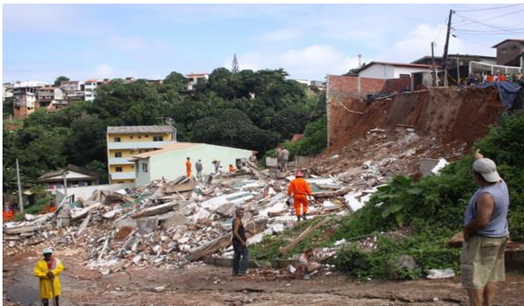
Figura 14 – Desabamento de um prédio e uma casa em Pernambués - 2010
