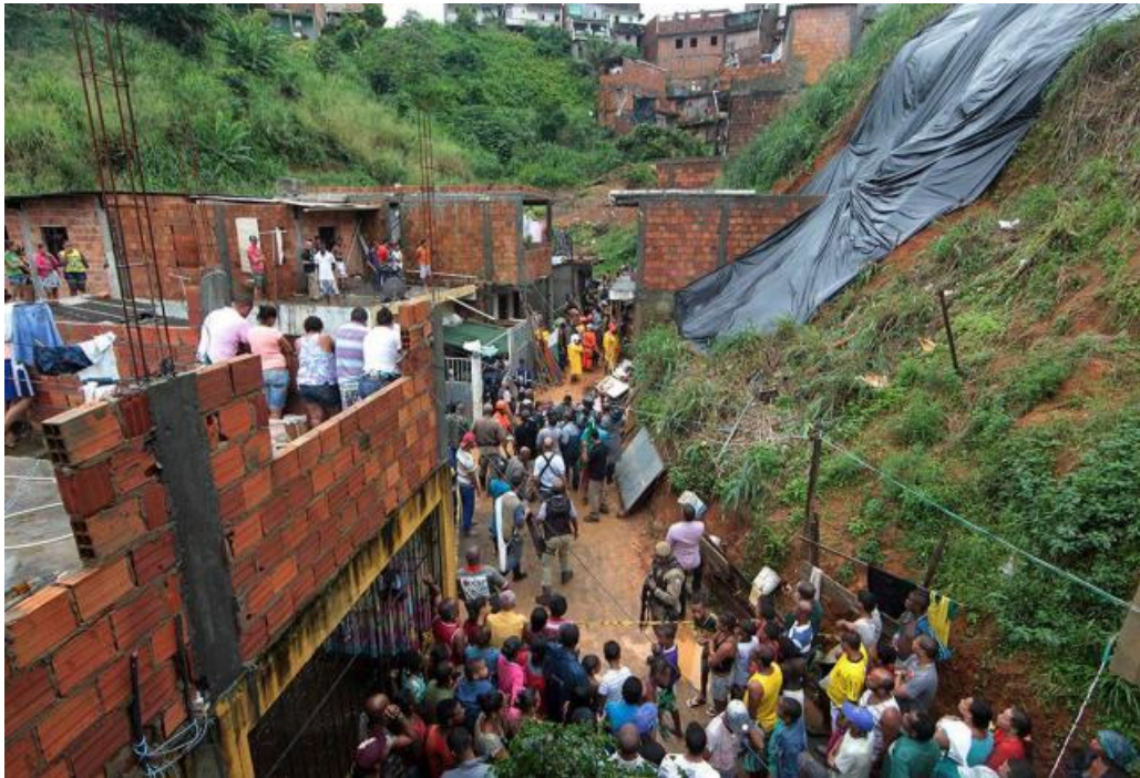
Figura 22 – Deslizamento de terra seguido de desabamento de imóvel em Fazenda Grande do Retiro – 2013
