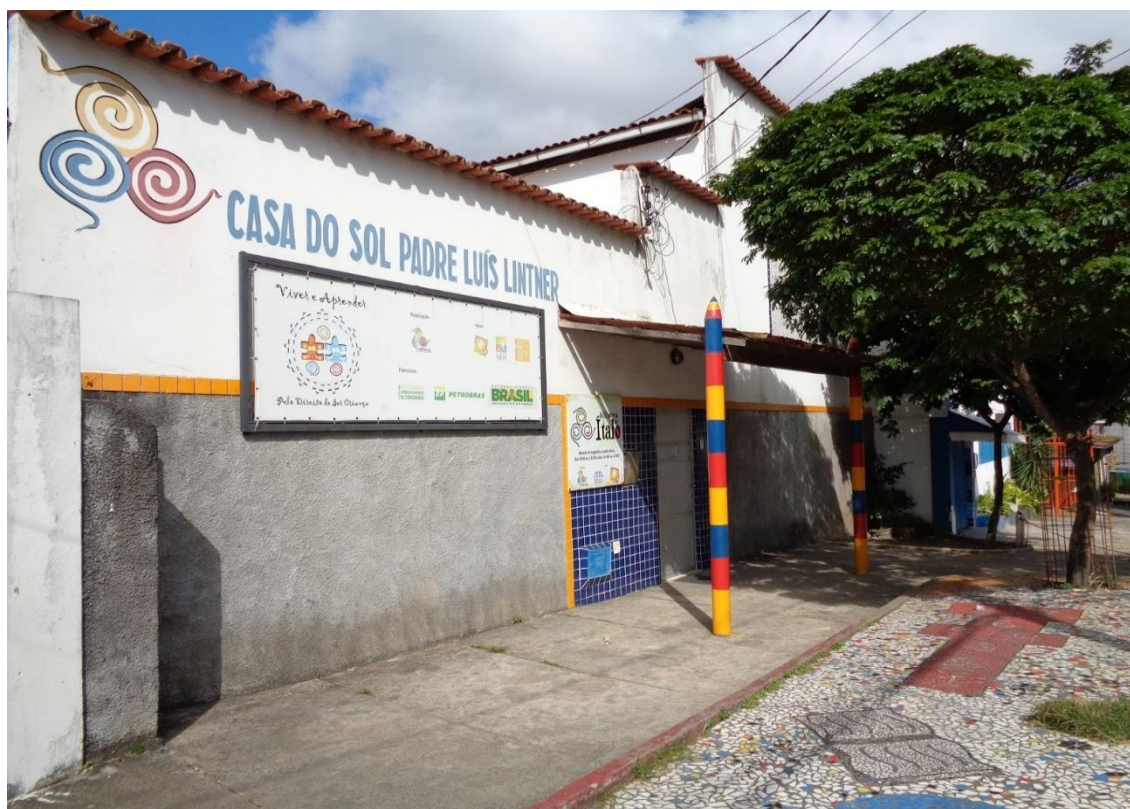
Figura 04 – Fachada da ONG Casa do Sol, em Cajazeiras V – imagem do Google.
