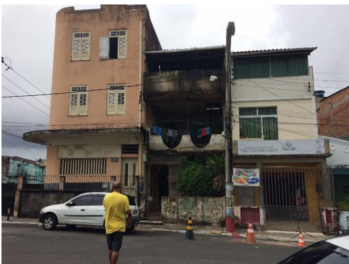
Figura 13: Edificações Praça Marquês de Olinda.
