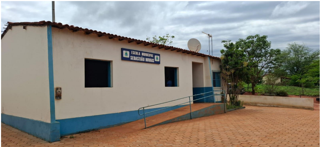
Figura 5 – Fachada e entorno da escola
