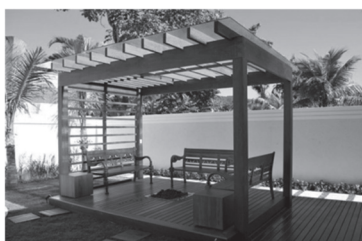
Figura 5 – Pergolado em madeira
