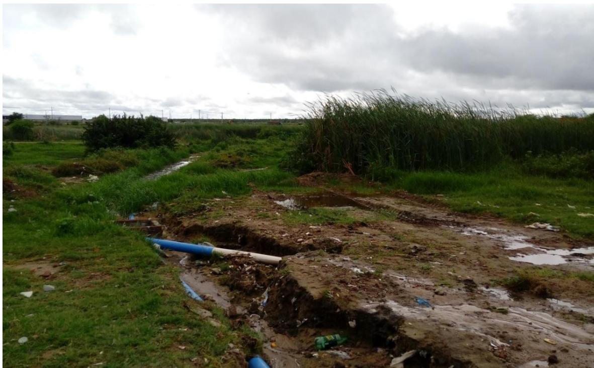
Figura 7 - A encanação da rede de esgoto e o lixo espalhado na Lagoa Capim Grosso.
