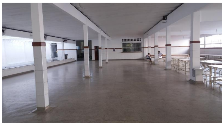
Figura 05: Área interna da Escola
