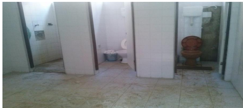
Figura 11: Banheiro da Escola
