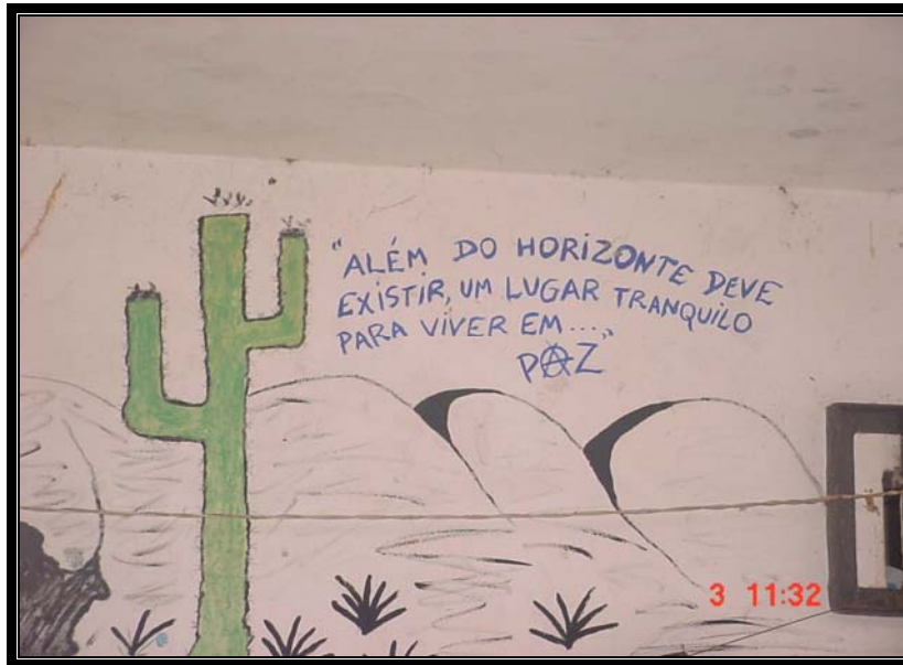
Fotografia 10 - Ala B - Vista externa das paredes do pátio
